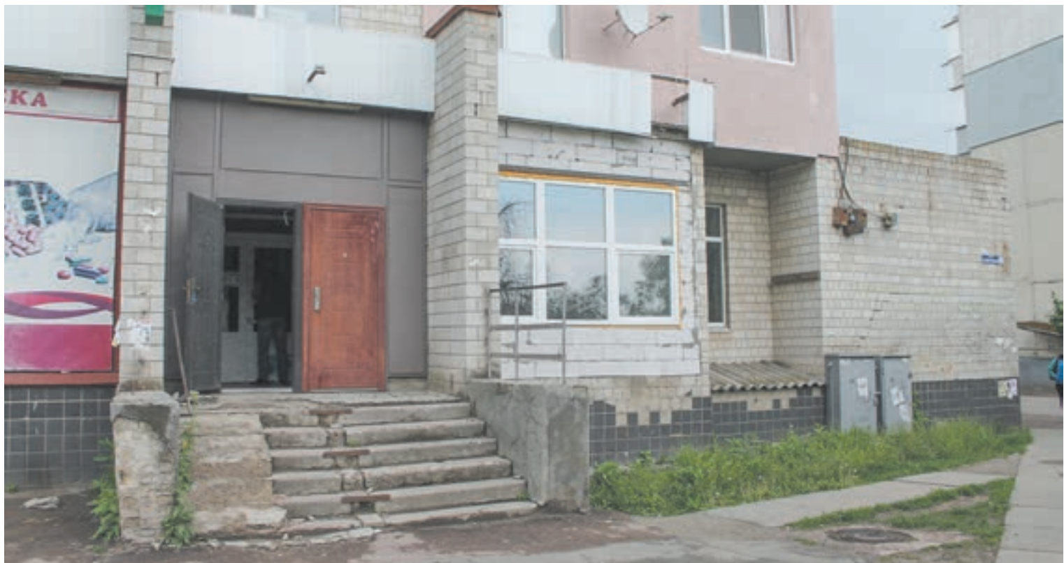
• Амбулаторія на вул.Глибоцька, 81. Про ремонт фасаду приміщення поки не йдеться. Не передбачено і парковок.
