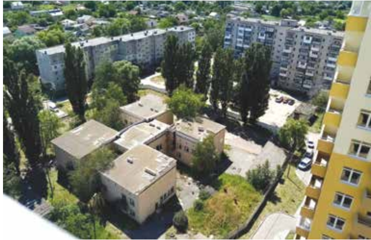
• Поряд із чотирма новими 18-поверховими будинками ЖК «Сонячний» руйнується будівля дитсадка.
