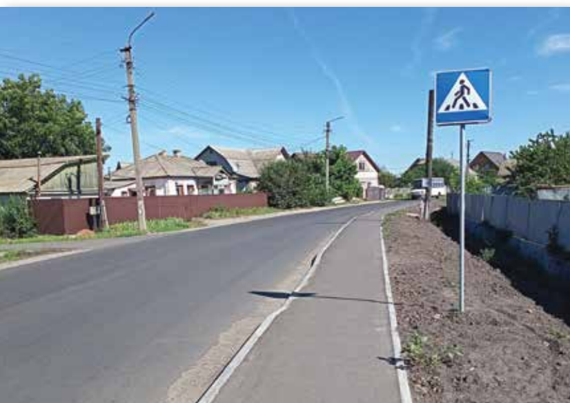
• Зроблено капітальний ремонт вул. Бежівка.
