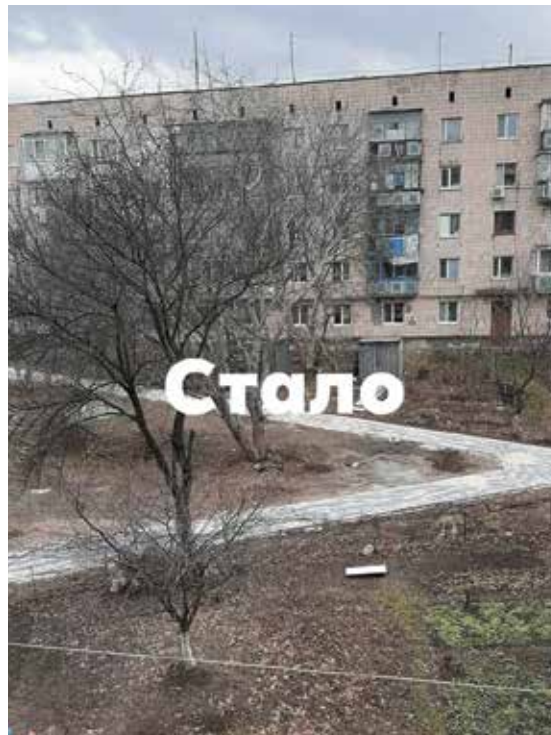
◀ Тротуар на вул. Лютневій між будинками № 12 та 16.
