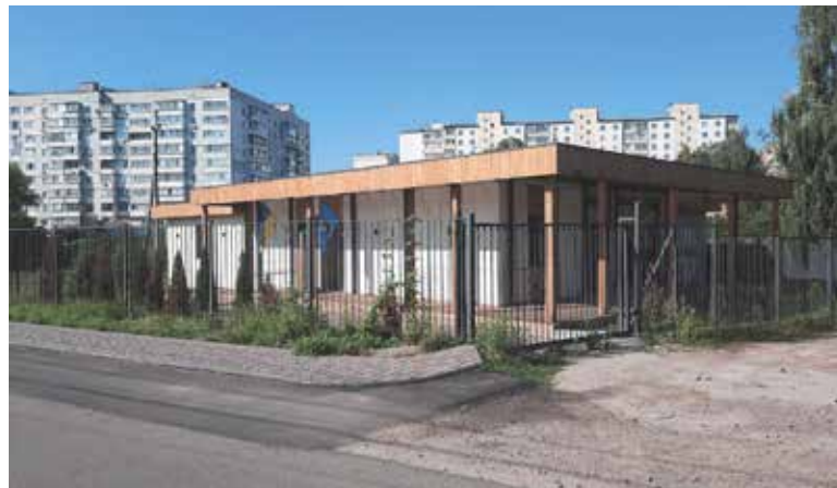
• Ігрове та спортивне обладнання, яке чекає на встановлення
