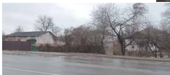
• Два будинки та земельні ділянки під ними на початку вул. Володимира Момота (поштова адреса Соцмістечка) викуплені мережею «АТЛ» під будівництво СТО.
