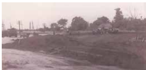
• Підготовка майданчика для будівництва кінотеатру, 1957 р.
